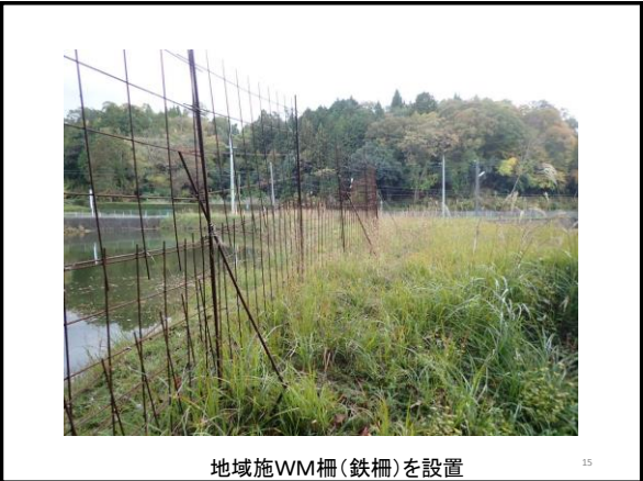
地域施WM柵(鉄柵)を設置
