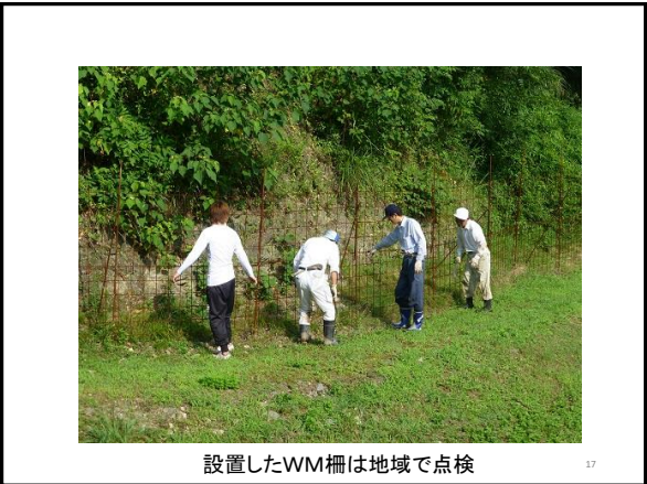
設置したWM柵は地域で点検
