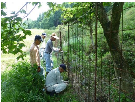
設置したWM柵は地域で点検
